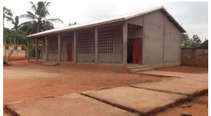
Progreso del colegio M. Matilde en Afagnan, Togo.
